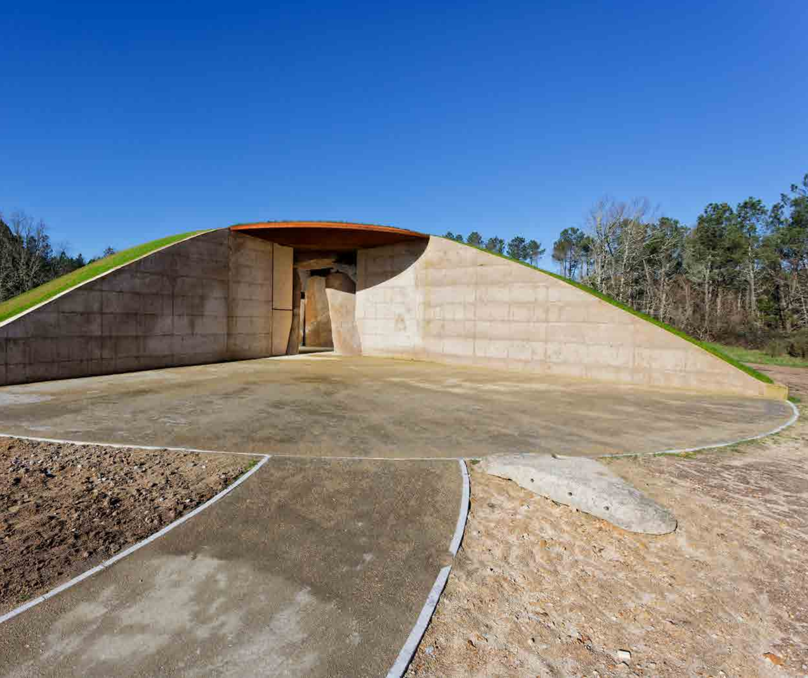
MONUMENTO APÓS OS TRABALHOS DE RESTAURO E ESTEIOS DECORADOS (2024) FOTOS: JOSÉ ALFREDO
